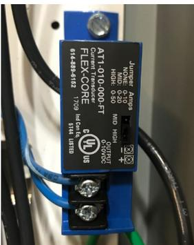
REMARQUE : Vérifiez qu'une ligne du fil triphasé passe par le transducteur actuel. Ce composant surveille l'intensité du moteur pour l'indicateur AW/CF.
